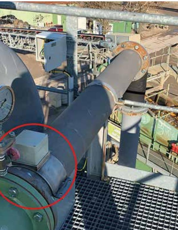
**IM HYDRAULISCHEN FÖRDESYSTEM** steuert der Geoscaner über die Online-Messung der Korngrößenverteilung die Nassklassierung.
